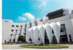
台南研發中心 (鑽石級綠建築)
