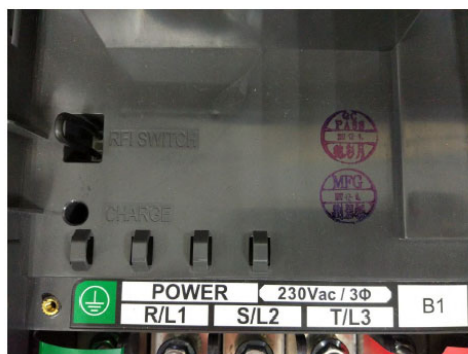
驅動器上的 RFI Switch
