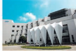
台南研發中心 (鑽石級綠建築)
