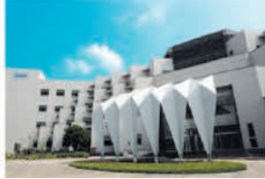
台南研發中心 (鑽石級綠建築)
